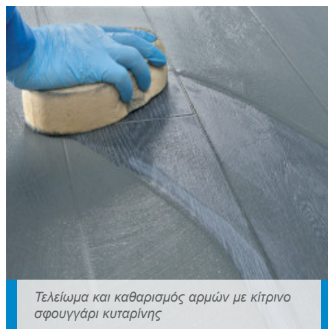
Καθαρισμός αρμών με σφουγγάρι Scotch-Brite® (αφού έχει αρχίσει η σκλήρυνση του αρμόστοκου)
