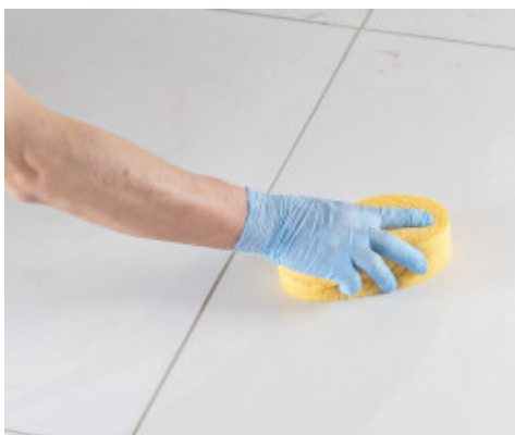
Καθαρισμός και φινιρίσμα του αρμόστοκου με σφουγγάρι κυταρίνης
