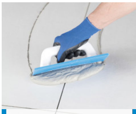
Τοποθέτηση Ultracolor Plus σε δάπεδο με λαστιχένια σπάτουλα σε πλακίδια τεχνητού γρανίτη
